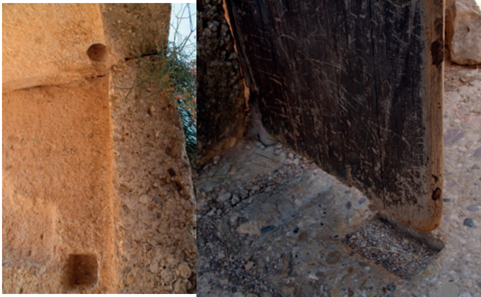
Рис. 3. Распашные ворота в Микенах. На изображении хорошо виден способ крепления, а также расположение двух засовов, поперечного, который, очевидно, запирает обе створки одновременно, и двух вертикальных, фиксирующих створки снизу
